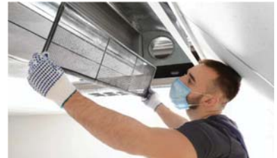
Dàn trao đổi nhiệt hoặc bộ lọc bẩn làm tăng sụt áp trong hệ thống
