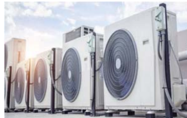
Phân tán thiết bị dẫn đến kém hiệu quả khi vận hành non tải
